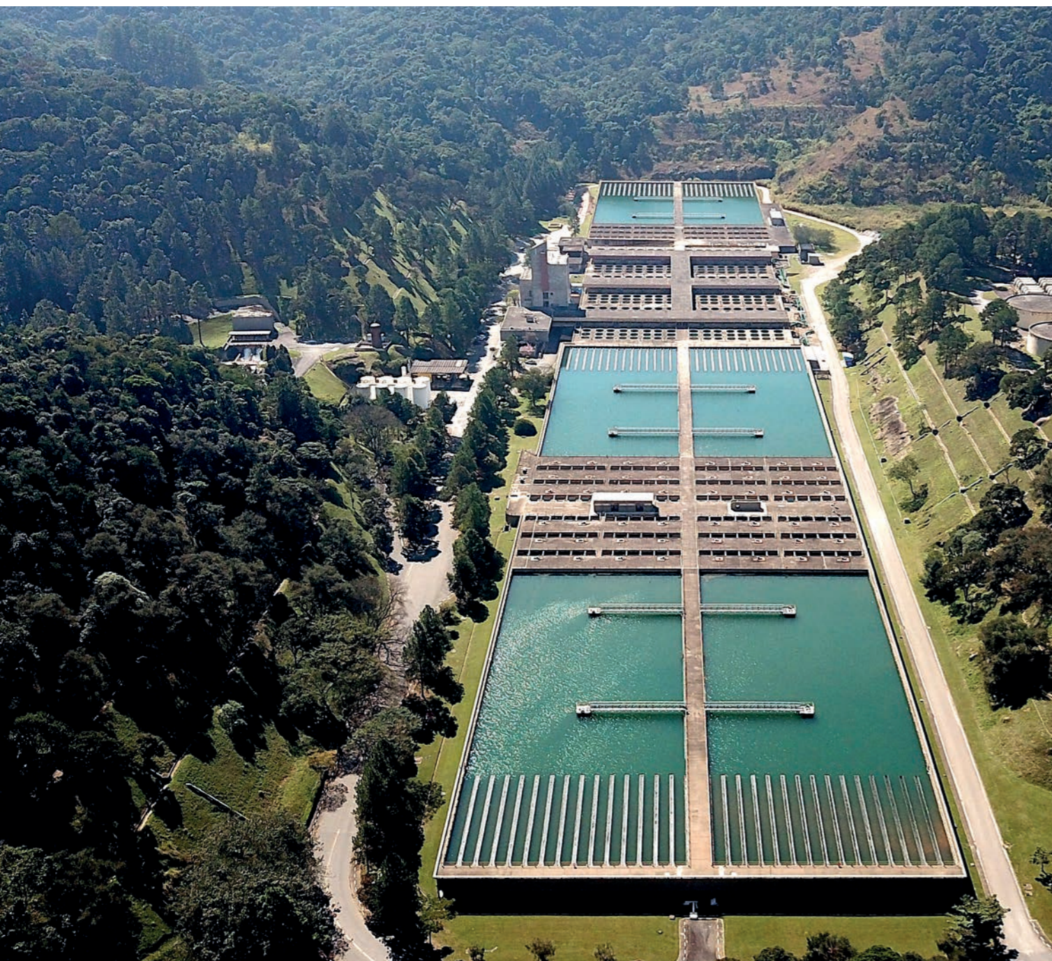
Cia de Saneamento Basico do Estado de Sao Paulo (Brazil)
